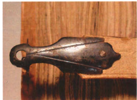
Afb. 14. Sluitoog (29) bevestigd aan slotlip (73)
