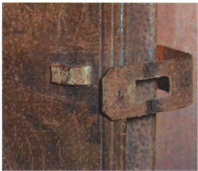
Afb.49. Stijf-riemsluiting, waarbij (verdwenen) sluitstift (62) door gat (35) in sluitriem (9) en stijtoog (63) wordt geschoven
